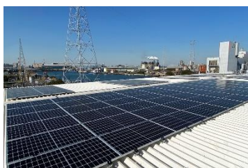
太陽光パネル設置
